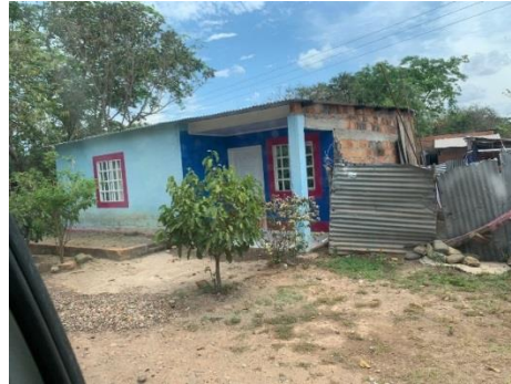
Foto 2: Casa corregimiento Boquerón
