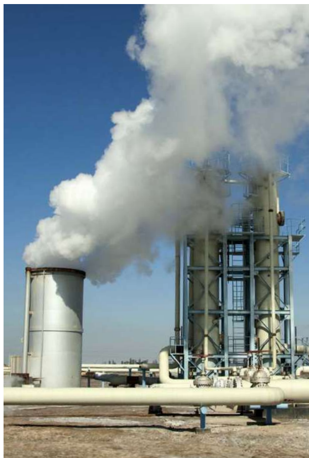
Central geotérmica Cerro Prieto. Mexicali, Baja California.
