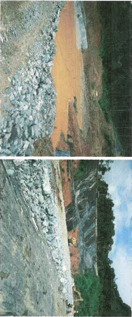
Barrera de contención y tina de Sedimentación, para control de erosión.
