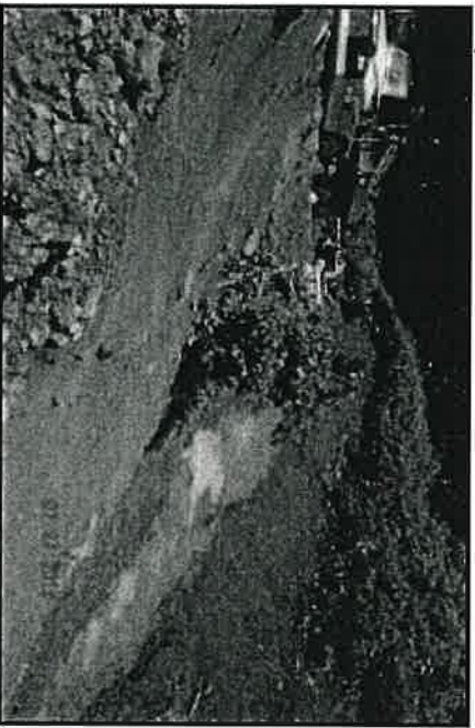
Fig.14.7. Vista del área de avanzada movimiento de cortes del Eastern Acces Road (540424 E, 978063 N), en esta zona no se observaron medidas de control temporal de erosión.
