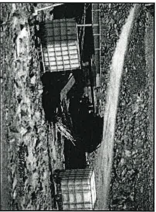
Fig. 39.1- 39.5 Área de Molino, área de construcción de la Planta Termoelectrica, se evidencia la falta de contención para sustancias peligrosas, la cual puede llegar a provocar derrames accidentales.
