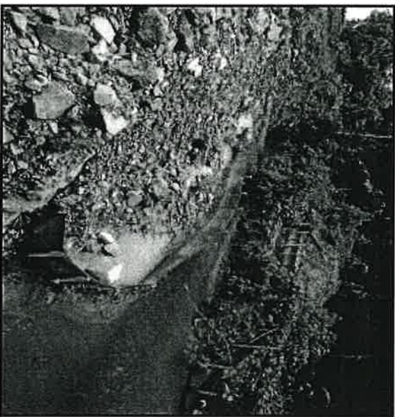
Fig. 14. 11. Barreras de sedimentos deterioradas en el camino de acceso decant túnel.(532765 E, 990767 N)
