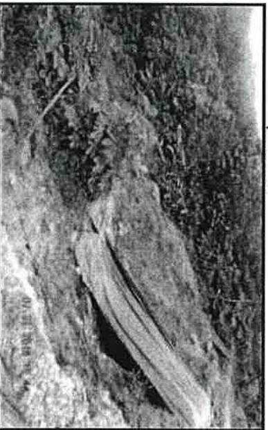
Fig.14.8. Movimiento de tierra por corte en una de los diques componente de la Presa Norte (536871E, 982961 N), sin las medidas preventivas necesarias para la minimización del proceso erosivo.
