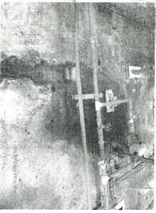
Fig. 16 Fugas de aguas residuales en las tuberías de la PTAR Cobre.
