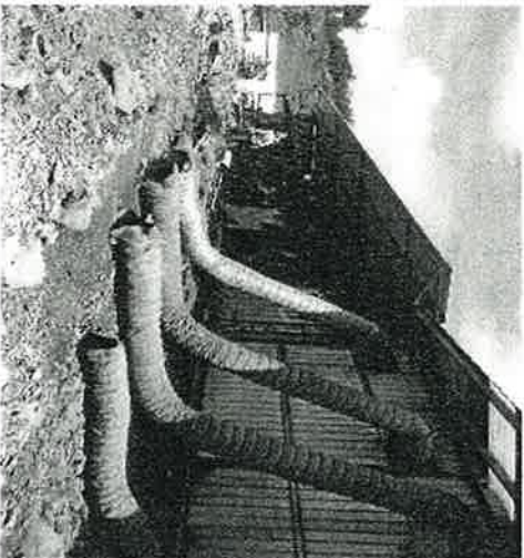
Fig. 13 Extractores ubicados en la parte trasera del Taller de Soldadura de Pylon.
