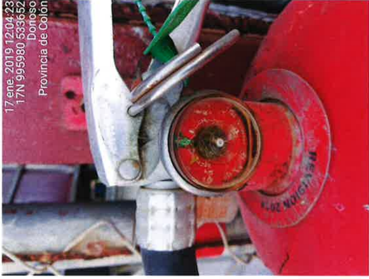
Fig.1.3. En el almacén de acopio de hidrocarburos, se evidencia extintor sin la presión adecuada para su funcionamiento.
