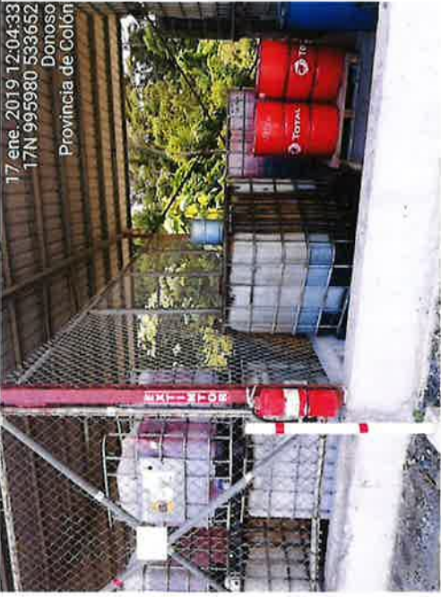
Fig.1.3. En el almacén de acopio de hidrocarburos, se evidencia extintor sin la presión adecuada para su funcionamiento.
