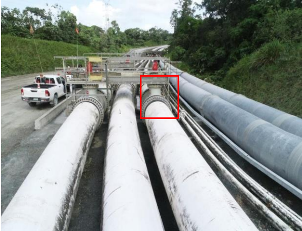
FotoN°13. Otra vista de la tubería R4 donde se presentó la fisura y posterior derrame del efluente de cola de relave.
