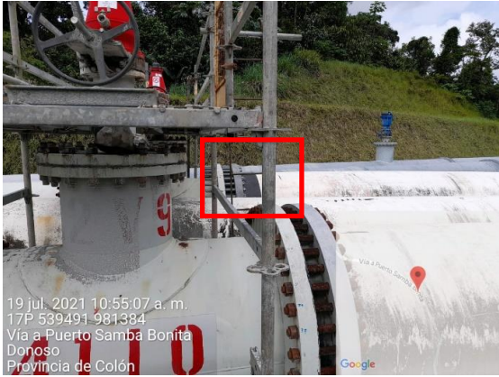
Foto N°7. Vista de la tubería R4 que sufrió la ruptura en una unión.
