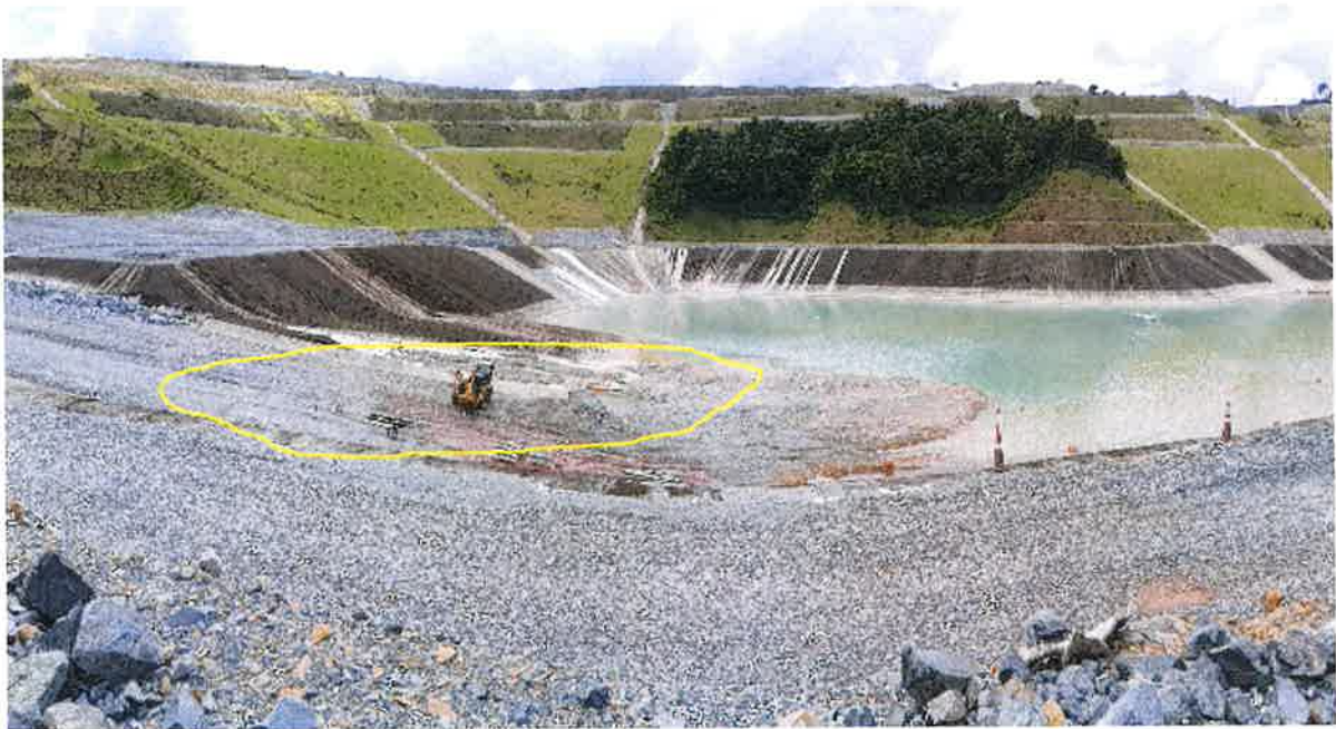
Fig. 9.1. Imágenes de la Poza No. 2 donde se visualiza la formación un delta de detritos arcillosos dentro de la poza.
