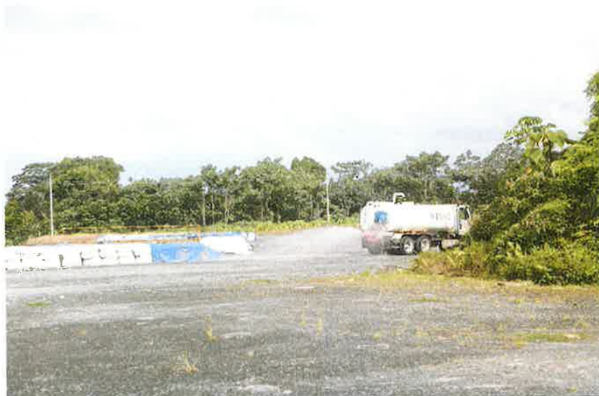
Fig. 6.2. Reutilización de aguas procedente de la Planta de Tratamiento del Puerto (riesgo de vías internas).
